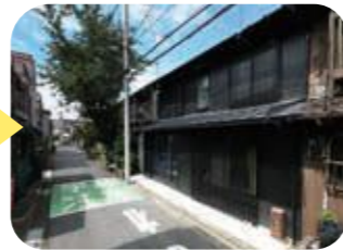
改修後の長屋外観
