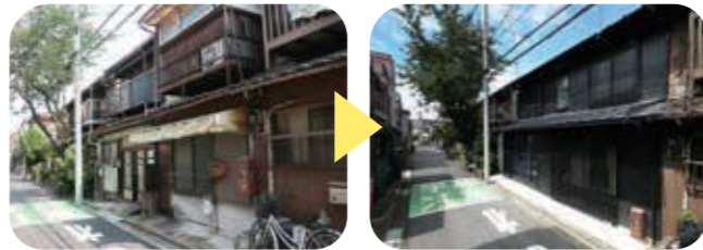
改修前の長屋外観
